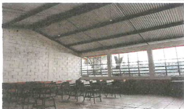
Foto 3: cambio de techo del módulo "C" listo.
