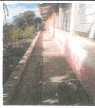
Foto 2: Bajadas de agua y cunetas reparadas.
