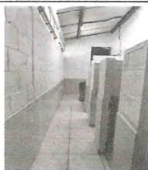
Foto 5: Sanitarios de mujeres remozados
